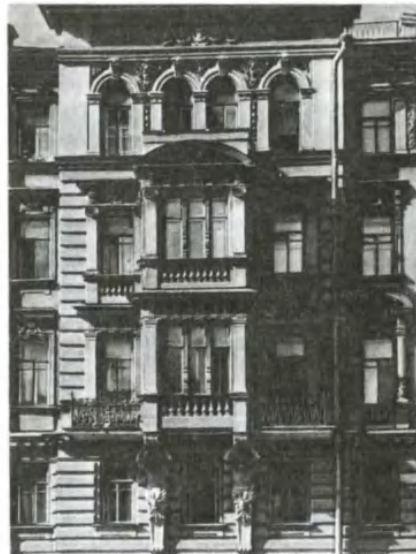
Доходный дом Ратькова-Рожнова на набережной Екатерининского канала в Петербурге. 1886. Архитектор П. Ю. Сюзор. Фрагмент фасада.
