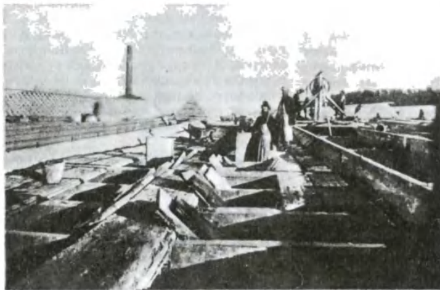
Строительство главного корпуса «АМО» для механнической обработки деталей. 1916.
