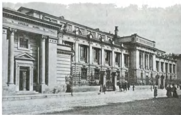
Здание московской конторы Государственного банка на ул. Неглинная. Архитектор К. М. Быковский.
