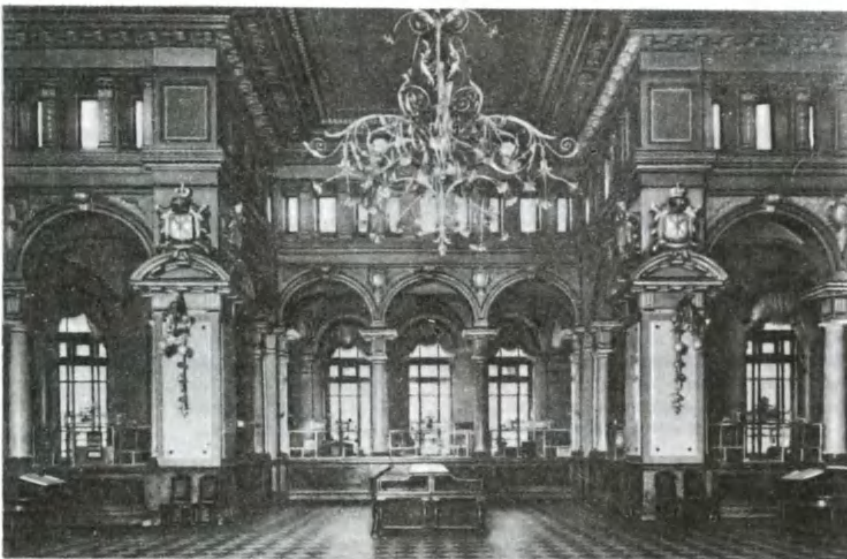
Операционный зал в здании Общества взаимного кредита на набережной Екатерининского канала в Петербурге. Архитектор П. Ю. Сюзор. 1888—90.
