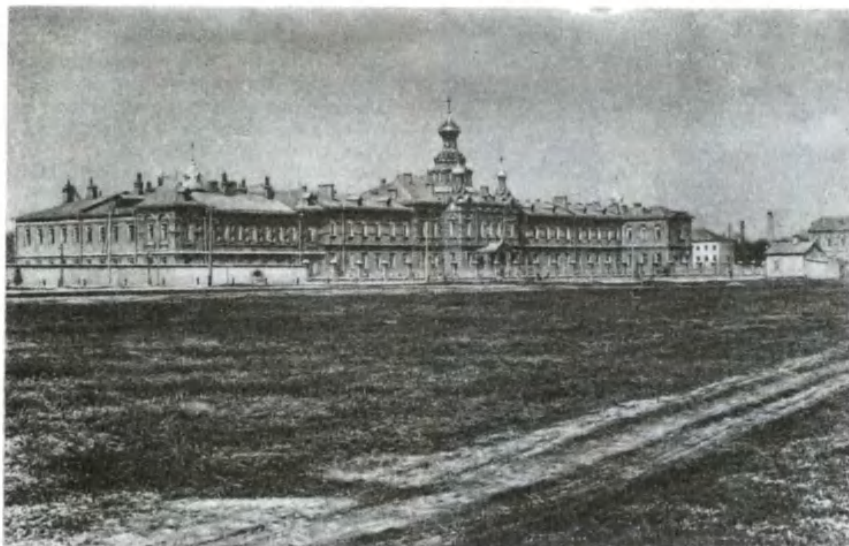
Бахрушинская больница в Москве.
